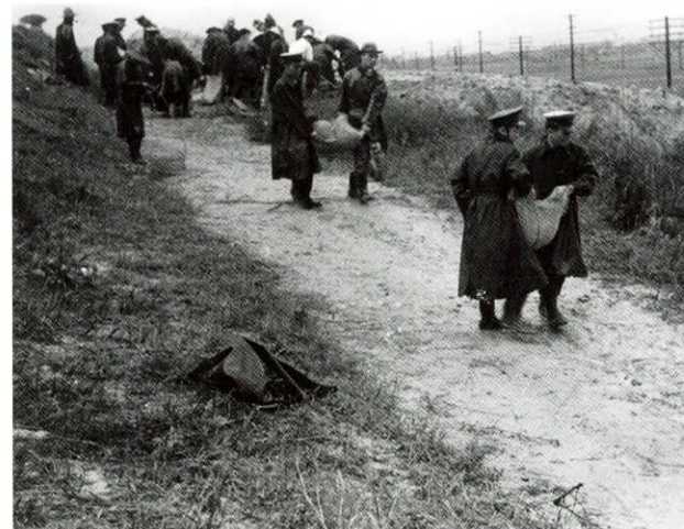
昭和31年の台風15号で破堤をくい止めた水防作業
